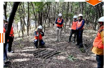
剪定枝等を利用した「祖朶柵(ソダサク)」作り。杭の作り方の説明を受けて作業開始です。
