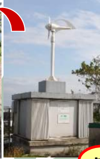
屋上ビオトープの池です 池の水は風力発電で循環させています
